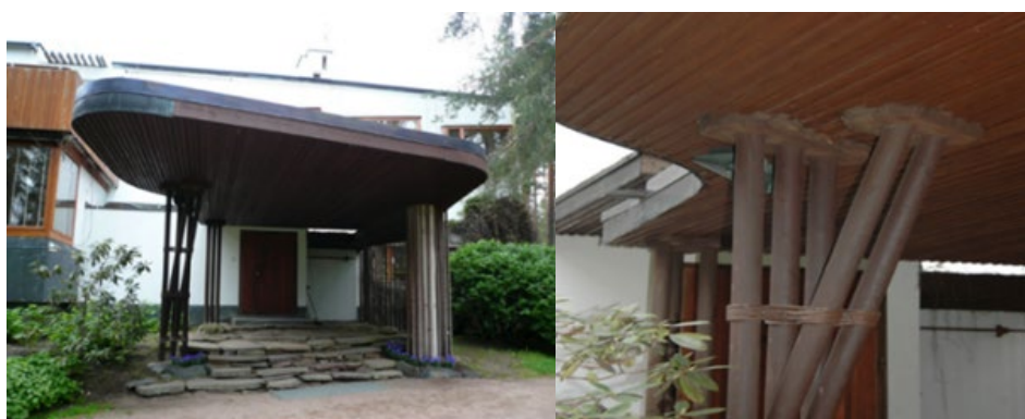
Figura 15 - La pensilina di ingresso e dettaglio delle colonne di sostegno.
