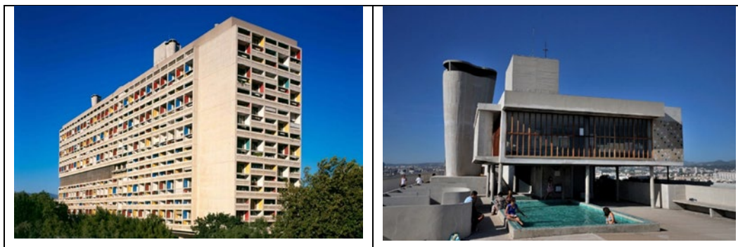
Figura 6 - Unité d'Habitation di Marsiglia, 1945-1952. Vista d'insieme e il tetto-giardino
