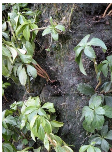
Figura 19 - Dettaglio del substrato d'impianto del Mur Vegetal della Caixa Forum a Madrid, 2007
