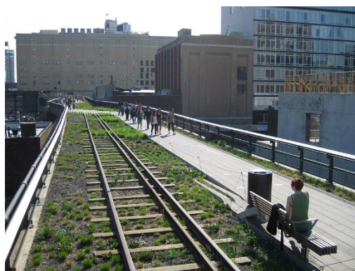
Figura 19 - Il tratto di binari ricostruito per preservare la memoria della linea.
