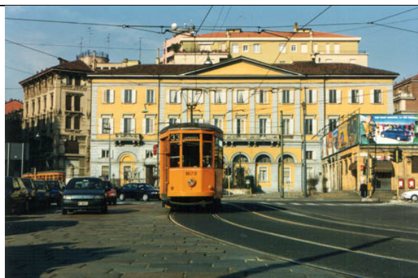
Figura 52 – L'edificio della stazione
