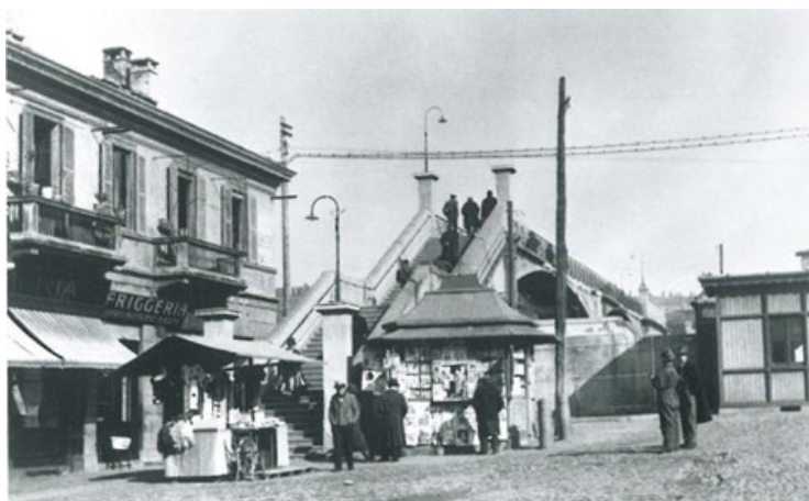
Figura 50 – Il sovrappasso ferroviario tra corso Como e via Borsieri
