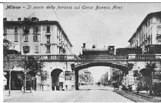
Figura 55 – Il sovrappasso ferroviario su corso Loreto
