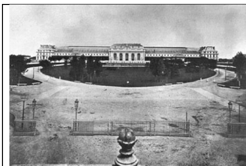
Figura 54 – La Stazione Centrale
