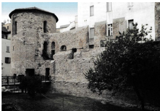
Figura 10 – Resti della cinta muraria massimiana.
