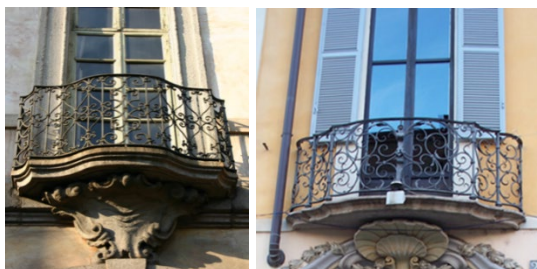
Figura 4 - Balconcini sopra i portoni d'ingresso dei primi del '700.
