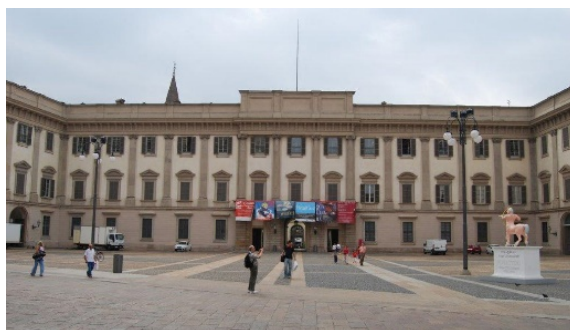
Figura 14 – Fronte del Palazzo Reale
