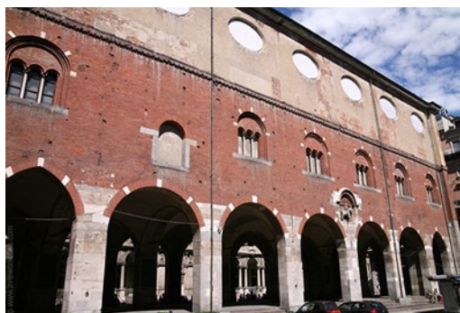
Figura 15 - Il nuovo piano dell'edificio del 1773. Le trifore riaperte al secondo piano nell'Ottocento.
