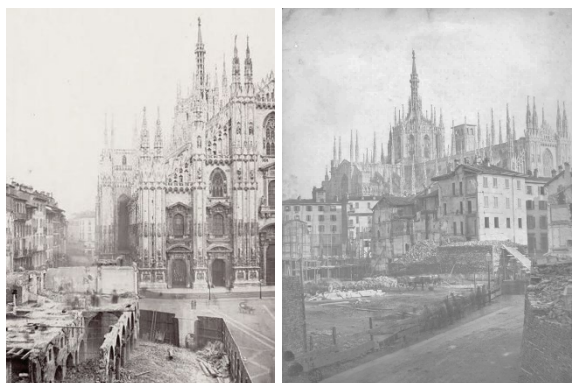
Figura 13 - Demolizione del Coperto dei Figini, 1862-1864.
