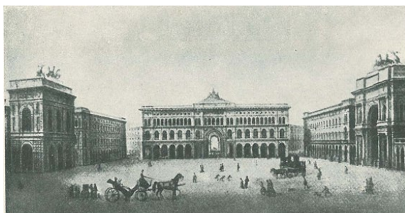
Figura 12 – Giuseppe Mengoni. La Loggia Reale di fronte all'arco di ingresso della Galleria e il Palazzo dell'Indipendenza sul fondo della Piazza del Duomo.
