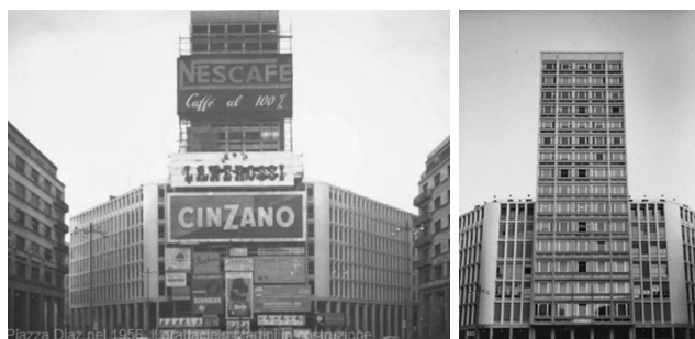
Figura 24 – La simulazione della Torre Martini in tubolari di ferro e la Torre Martini vista dalla piazza. Stampa fotografica b/n. (Archivio Luigi Mattioni)
