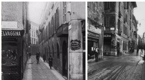
Figura 4 - Vicolo di San Giovanni in Conca e Via Paolo da Cannobio all'altezza di via Bottonuto
